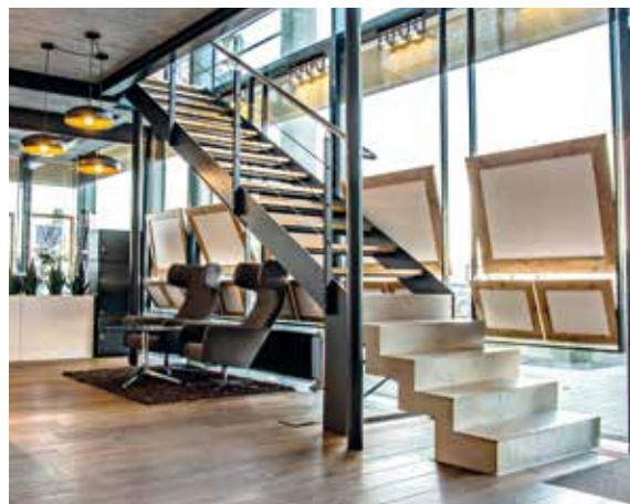
Innentreppe Stahl mit Holz kombiniert
