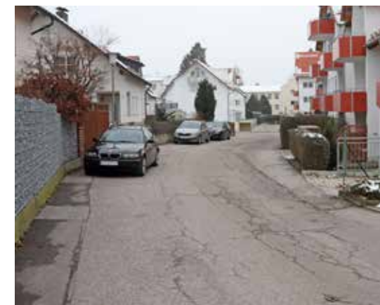
Die gesamte Martin-Zeiler-Straße bis zur Einmündung in die Günter-Eich-Straße ist bei der Neugestaltung einbezogen.
