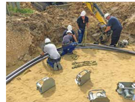
Baustelle Trochtelfingen, 110-kV-Kabelverlegung
