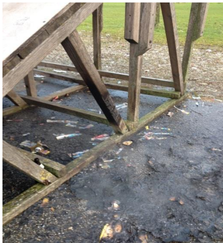
abgebrannte Mülltonne + beschädigte
