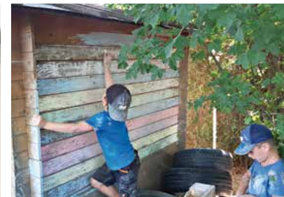
Kinder verpassen Gartenhaus neuen Anstrich.
