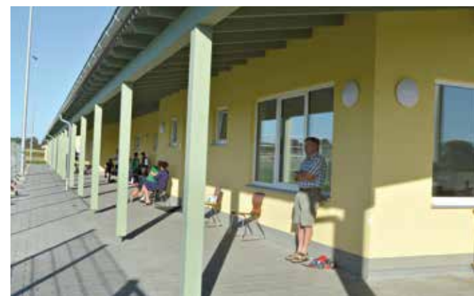
Das langgestreckte Vereinsheim beherbergt neben dem Kiosk mit Aufenthaltsraum die Umkleidekabinen, die Duschen, das Büro und die gesamte aufwändige Technik.
