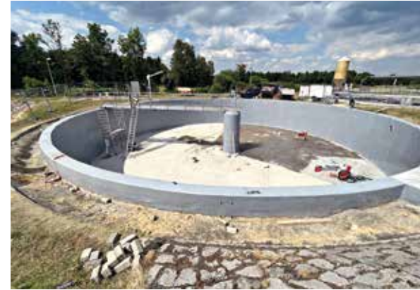
Umbau Kläranlage: Sanierung zweites Belebungsbecken, Schwebbettverfahren und Erneuerung Lüftung
