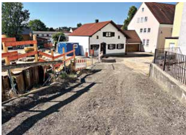
Metzgergasse Erneuerung Kanal und Wasser
