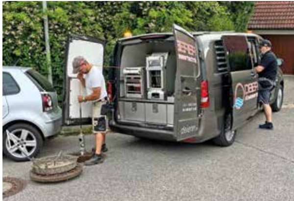
Kanaluntersuchungen, TV-Verfilmung, Reinigung
