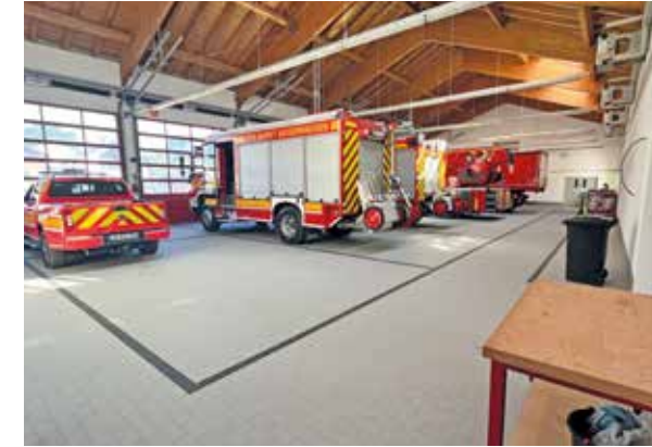
Feuerwehrhaus Sanierung Hallenboden und Erneuerung Abgasabsauganlage
