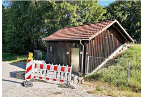
Neue Stromleitung zur Druckerhöhungsstation Westersbergham inkl. Notstromversorgung
