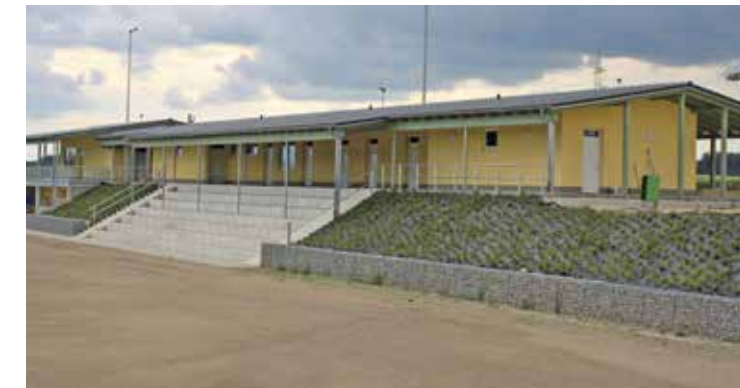
Blick auf den Umkleide-trakt mit der Tribüne zum Hauptspielfeld
