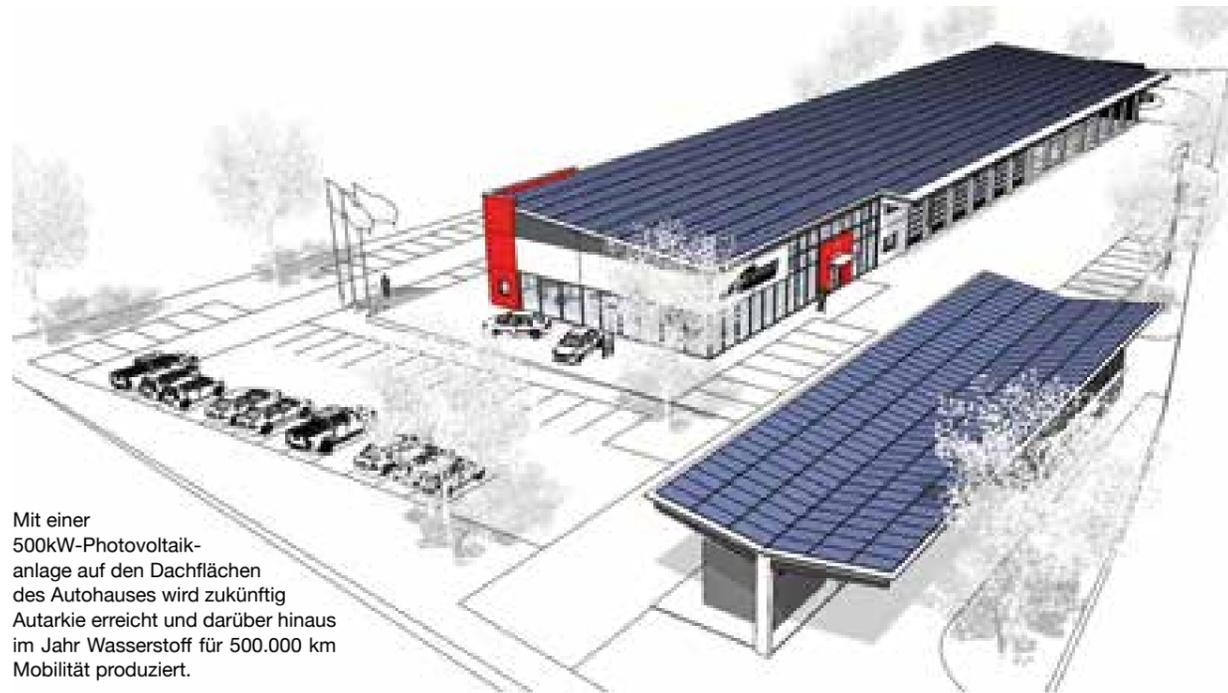
Mit einer 500kW-Photovoltaikanlage auf den Dachflächen des Autohauses wird zukünftig Autarkie erreicht und darüber hinaus im Jahr Wasserstoff für 500.000 km Mobilität produziert.
